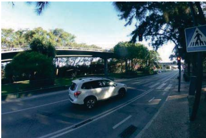
El tramo donde se desarrollará esta segunda fase de las obras. INFORMACIÓN
