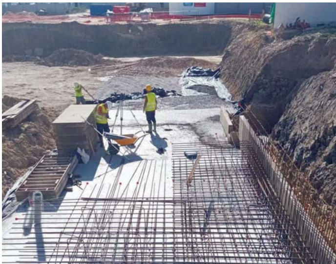
Las 81 viviendas que se están construyendo actualmente en la Ronda del Estero. VIVA
