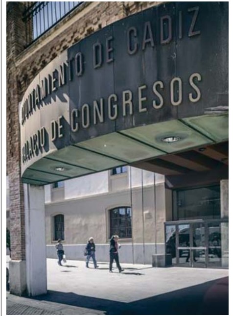
El Ayuntamiento reparará la montera del Palacio de Congresos. VIVA
